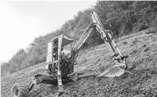
Terrassierung mit Einsatz des Baggers.
