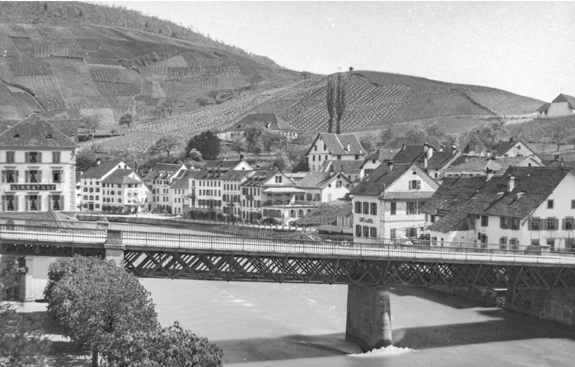
Schiefe Brücke und Goldwand, um 1898.
