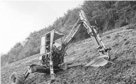
Terrassierung mit Einsatz des Baggers.
